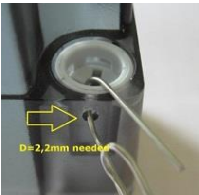
Abbildung 1 Manipulationsschutz durch Plombierung
